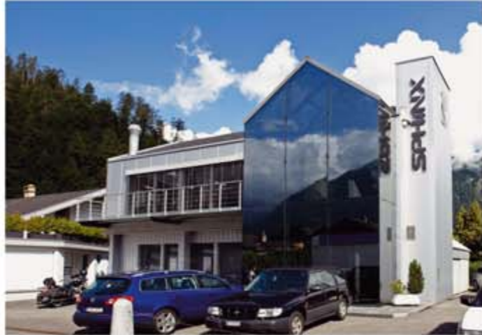
Entwicklung, Produktion, Lager, Montage und Administration, alles unter einem Dach. Und im UG der Schiesskeller.
